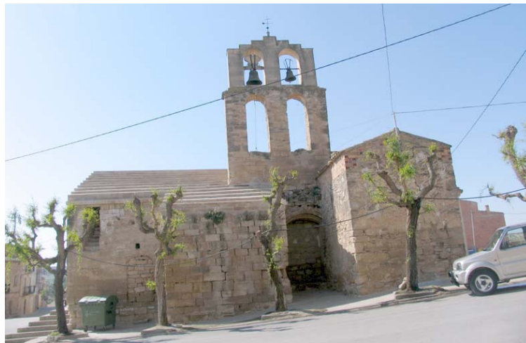
Església de Sunyer. Recuperació porta lateral.
