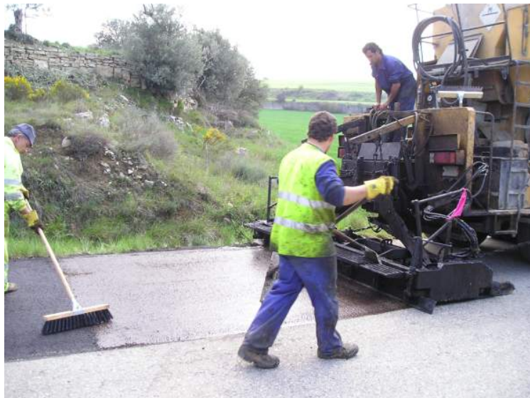
Impermeabilització del ferm a la carretera LV-2143, a Gramuntell
