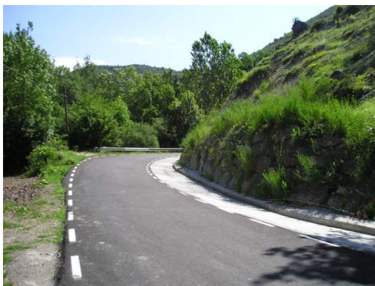
Detall d'un revolt de la carretera LV-5212, a Malpàs
